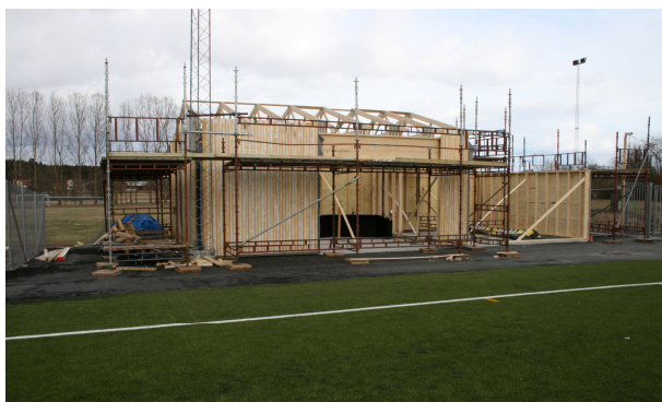
Förrådsbyggnad och kiosk under uppbyggnad.
