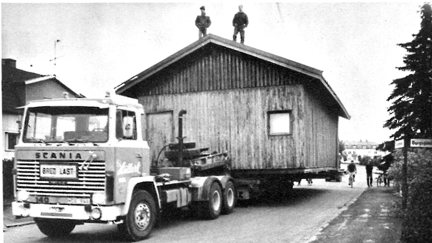
Telebaracken på Brovallen. Äntligen! — Foto NLT. Nu kan vi börja rusta upp hela anläggningen.
